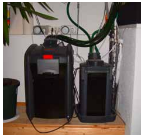
Les deux filtres externes.
