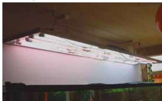
La galerie d'éclairage relevée grâce aux câbles et aux poulies.
